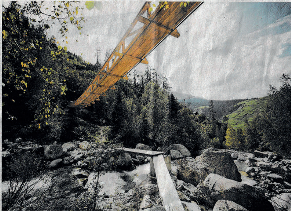
Die neue Hängebrücke Punt da Mulins am Dorfrand von Curaglia ist aus Holz.
